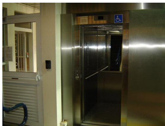
Vista do elevador - Bloco ICMC-6
