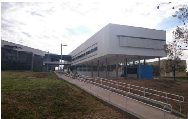
Rampa de acesso e vista geral
