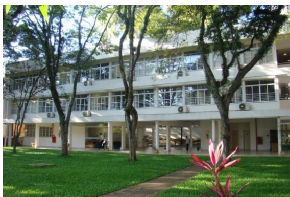
Figura 25 - Vista da Fachada do Bloco ICMC 3
