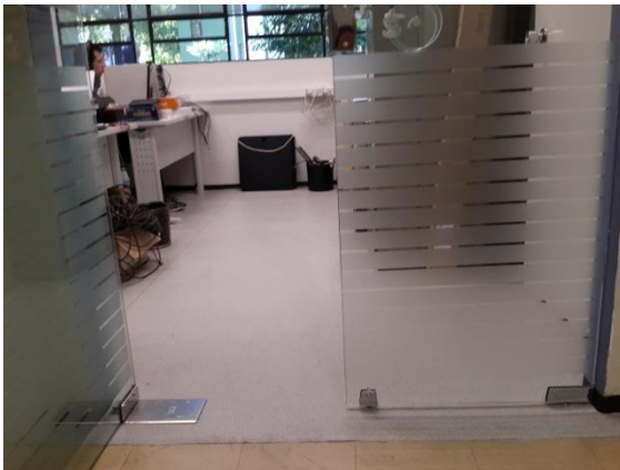
Figura 72 - Vista do piso da sala 1-001
