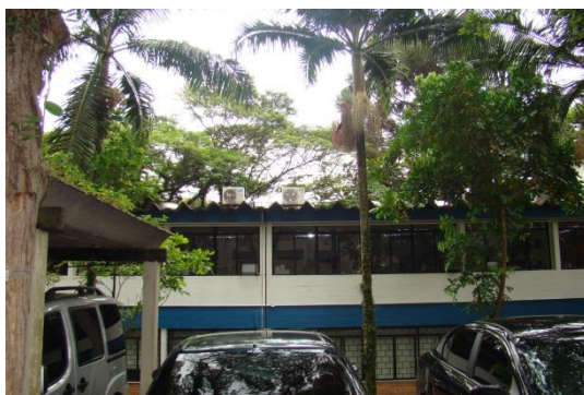
Figura 54 - Vista da fachada do Bloco ICMC-3
