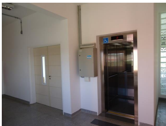
Figura 20 - Vista do elevador do 2º piso
