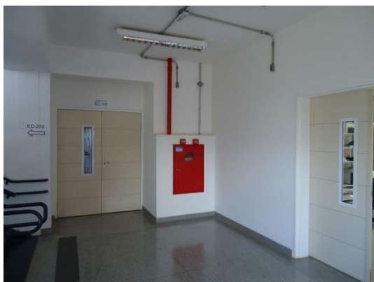
Figura 12 – Vista do corredor do 1º piso
