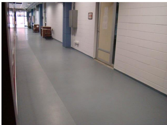
Figura 64 - Vista da área de circulação entre o museu e salas de aula
