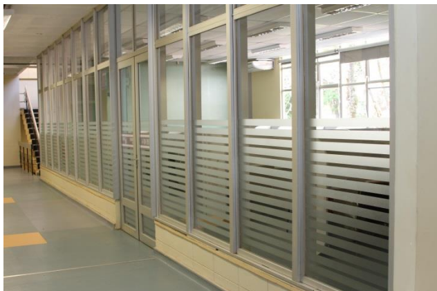
Figura 66 - Vista externa da sala 4-124
