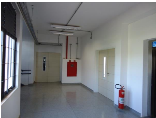
Figura 6 - Vista do corredor do piso térreo
