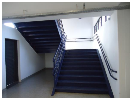
Figura 7 - Vista escada do piso térreo
