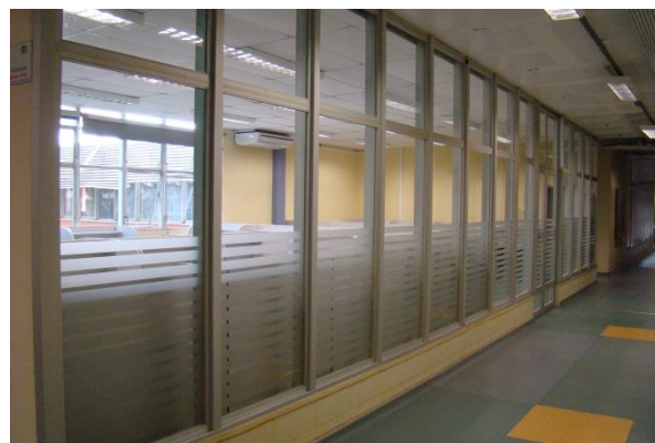
Figura 22 - Vista externa da sala 4-124
