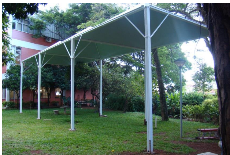
Figura 78 - Tenda instalada atrás do Bloco ICMC-4
