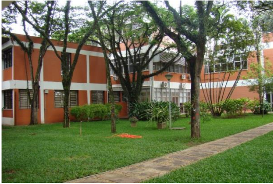
Figura 56 - Vista externa do Bloco ICMC-4
