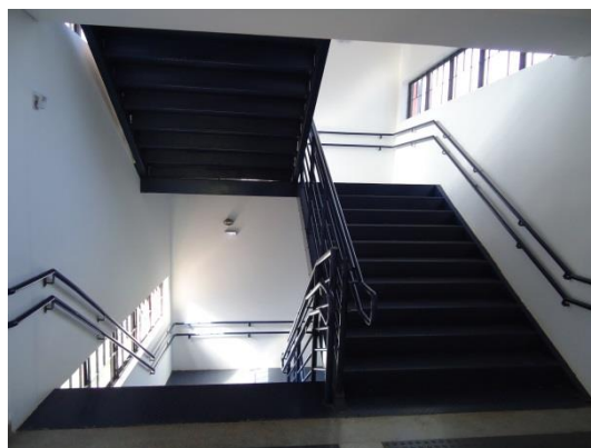
Figura 14 - Vista da escada do 1º piso
