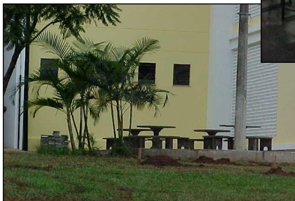
Vista parcial da parte posterior do Bloco ICMC-5 (ao lado) e vista parcial de uma das salas de aula (acima)
